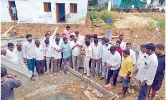
రోడ్డు నిర్మాణ పనులు ప్రారంభిస్తున్న నాయకులు ముని
